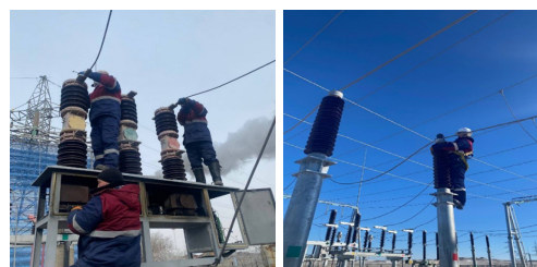
Гүйдлийн трансформатор солих ажлын явц
