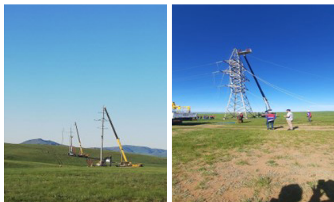
110 кВ-ын Хархорин-А, Б АШ-д гэмтэл устгаж, сэргээн босголт хийж байна.
