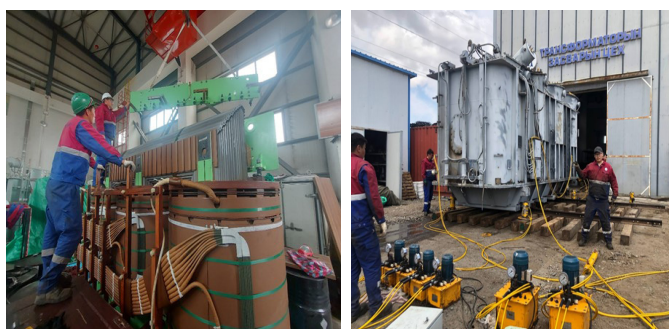
Трансформаторын засварын ажлын явц
