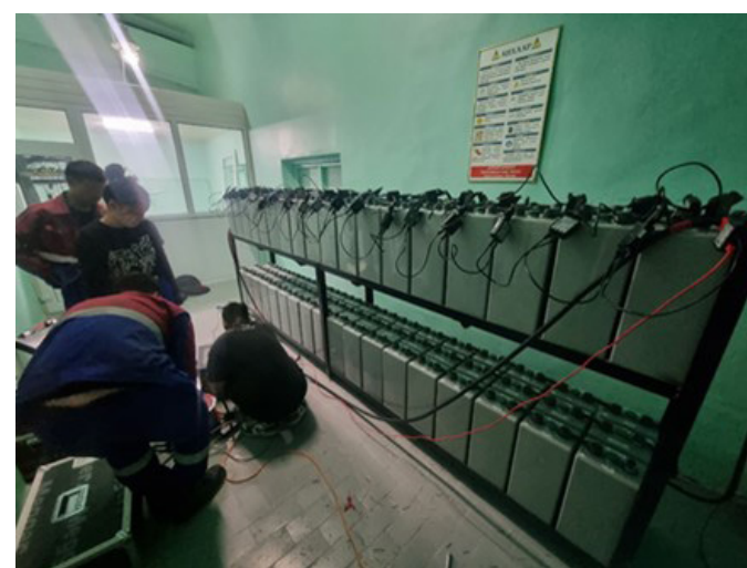
Батерейнд хэмжилт туршилт хийж байна
