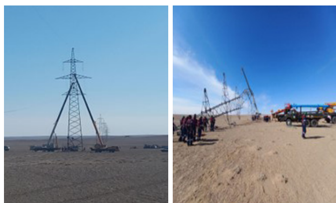
220 кВ-ын 215, 216-р шугамын тулгуур №32-д гэмтэл устгаж, сэргээн босголт хийж байна.
