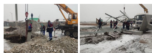
№13 анкер тулгуурын хөл тавих тулгуур угсралтын ажил
